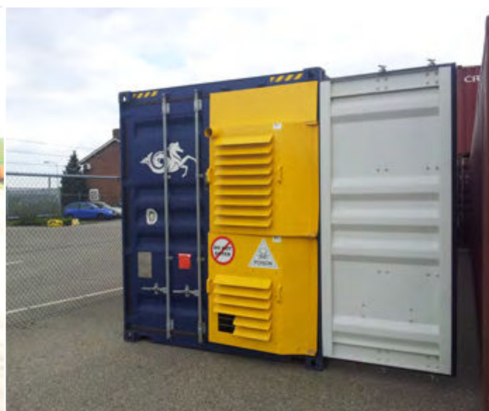
Ontgassing door natuurlijke ventilatie. (© S. Faber)
